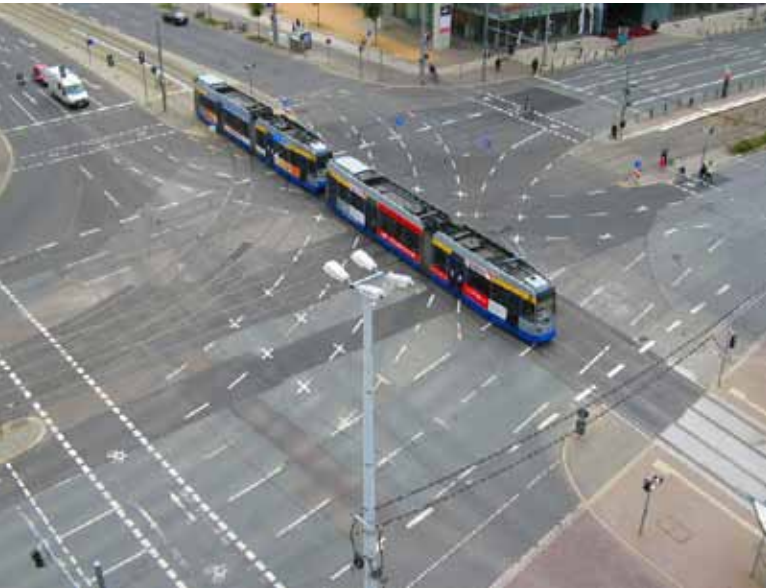
Verkehrsknotenpunkt in Leipzig: Einordnung und Richtungen sind geregelt, Grundvoraussetzung für eine reibungslose Verkehrsführung.
